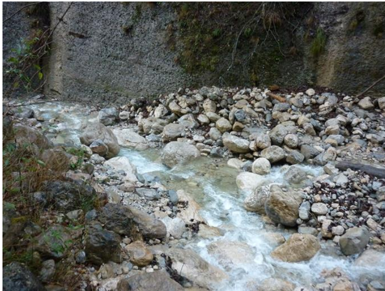
Figure 38: Accumulations de sédiments grossiers juste avant un coude imposé par la paroi rocheuse (sur la Roize)
